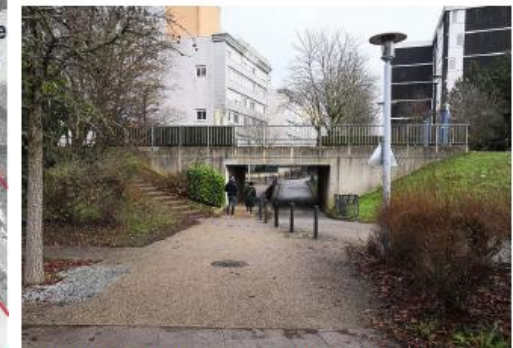
la rue Darius Milhaud, un espace public peu visible, aménagé comme une allée résidentielle ou comme une route (passage inférieure).
