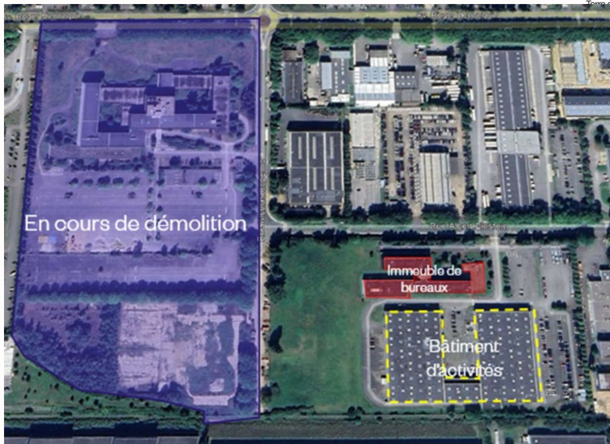
Figure 4 : Utilisation des différents bâtiments sur le site
