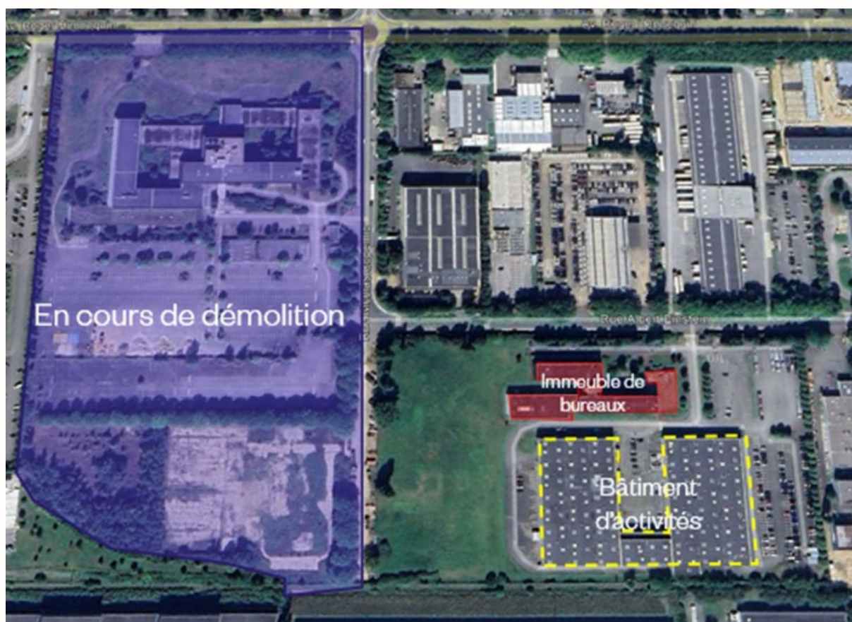
Figure 7 : Utilisation des différents bâtiments sur le site
