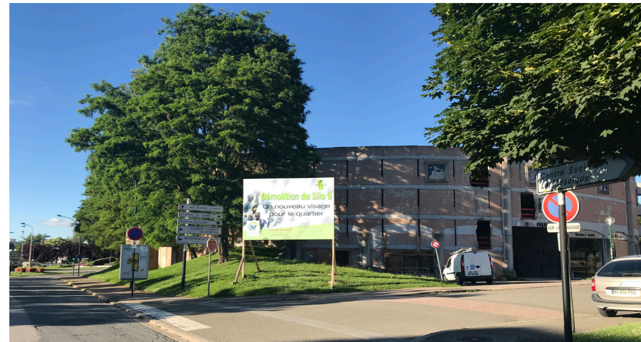
L'ancien parking silo 9 de Plaisir, démoli en 2019
