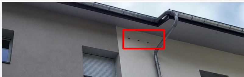
Nichoir triple à martinets intégré dans l'isolant sur le site pilote de Grand Aigueblanche (73) © Ilan Badaoui
