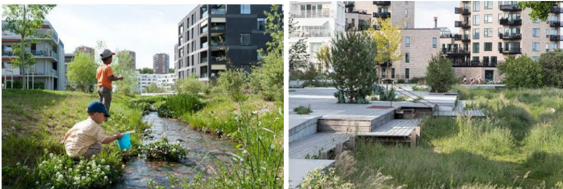
Figure 27 Exemple ouvrages à ciel ouvert intégrés dans le paysage (programme des espaces publics, La Fabrique Urbaine / Florence Mercier Paysagiste / INGETEC / EODD / Fonceo Citeliance, 2024)
