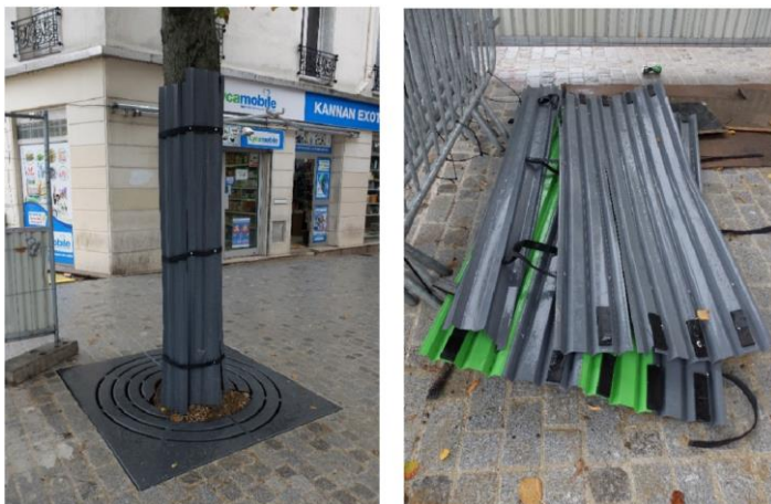
Figure 19 Photographie de protection d'arbre en panneaux souples en bardage PVC (Phytoconseil, 2023)
