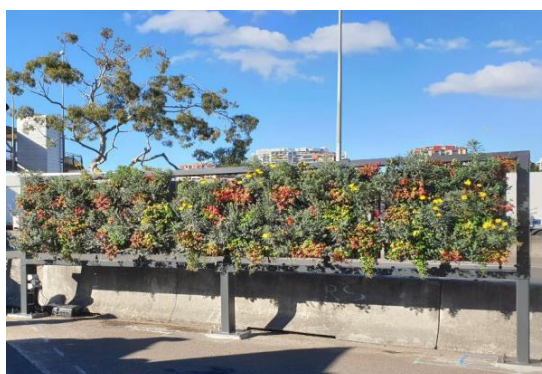
Figure 90 : Exemple de système de biofiltration d'air : Panneaux végétalisés biofiltrants installés le long d'une autoroute (University of Technology Sydney, 2019)
