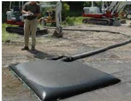
Figure 14 : Sach filtrant pour assainir les eaux sur chantier
