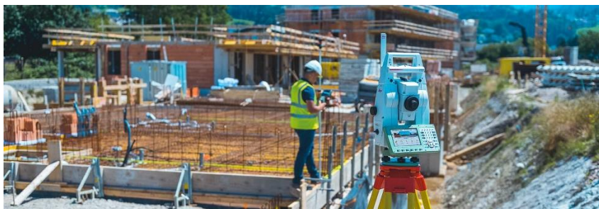
Figure 10 Suivi topographique en phase de travaux (Hexagon, 2023)
