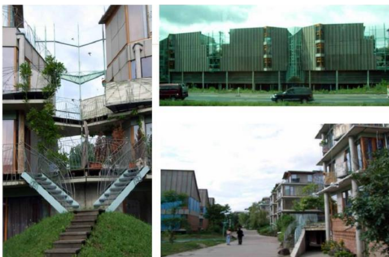
Figure 99 Projet Nutheschlange (Postdam – Allemagne) avec création d'écrans translucides entre les bâtiments
