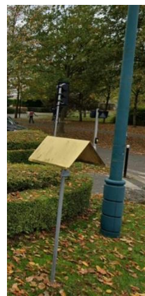
Figure 150 Repère de signalisation de la présence de canalisation de gaz (Source : Suez Consulting, 2024)
