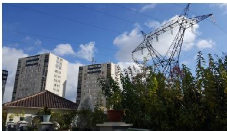
Figure 160 Ligne très haute tension traversant le quartier
