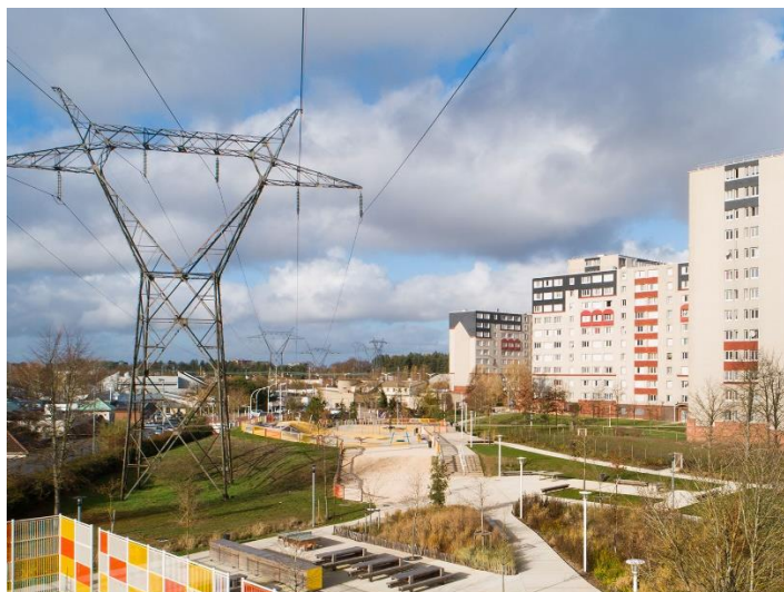
Figure 151 Ligne électrique Haute tension : Elancourt-Saint Aubin et Elancourt – Villejust Z Montjay à 225 000 V (WALD, 2023)
