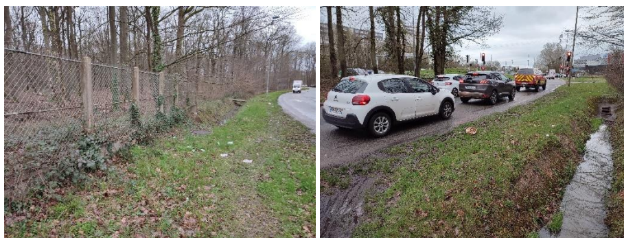
Figure 183 : Ruptures d'aménagements piétons et cyclables RD58 vers le Sud (CDVIA, 2024)
