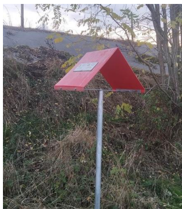
Figure 149 Repère de signalisation de la présence de l'Oléoduc (Source : Suez Consulting, 2024)
