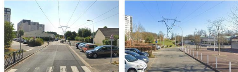
Figure 4 : Liaison très Haute tension présente sur le quartier (CASQY, 2025)
