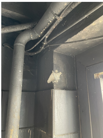
Prélèvement - P49 : RDC / Sanitaires 1 - Enduit- (Absence d'amiante)
