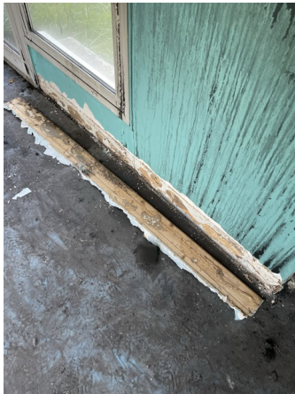
Prélèvement - P18 : RDC / Couloir 1 - Colle de plinthe- (Absence d'amiante)
