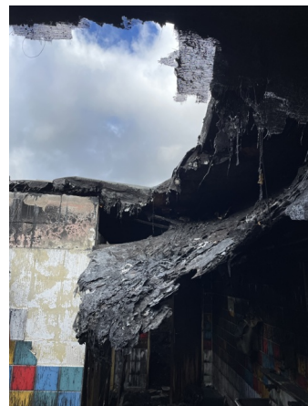
Prélèvement - P50 : RDC / Sanitaires 1 - Revêtement d'étanchéité- (Absence d'amiante)
