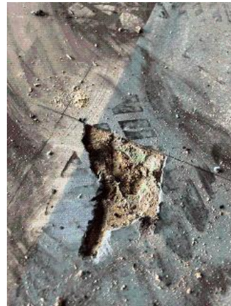
Prélèvement - P79 : RDC / Classe 6 - Ragréage- (Absence d'amiante)
