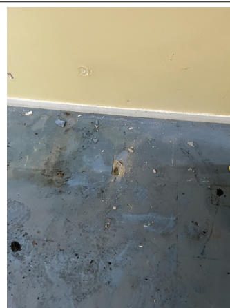
Prélèvement - P1 : RDC / Bureau 1 - Dalle de sol, Colle- (Absence d'amiante)
