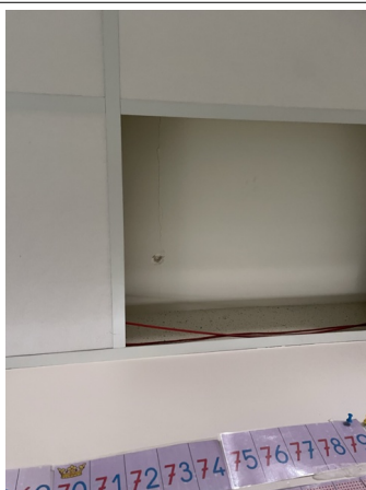
Prélèvement - P12 : RDC / Salle de réunion - Bande calicot- (Absence d'amiante)
