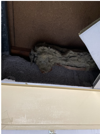
Prélèvement - P24 : RDC / Bibliothèque - Enduit- (Absence d'amiante)
