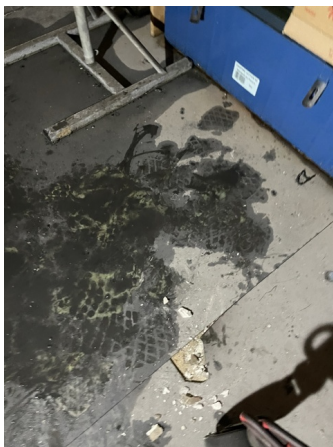
Prélèvement - P88 : RDC / Réserve 3 - Lé plastique- (Absence d'amiante)
