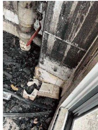
Prélèvement - P47 : RDC / Sanitaires 1 - Colle de plinthe- (Absence d'amiante)
