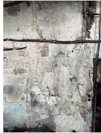
Prélèvement - P92 : RDC / Classe 8 - Enduit- (Absence d'amiante)
