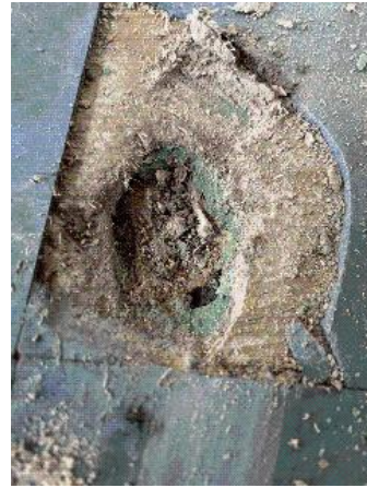
Prélèvement - P3 : RDC / Bureau 1 - Dalle de sol, Colle bitumineuse- (Absence d'amiante)
