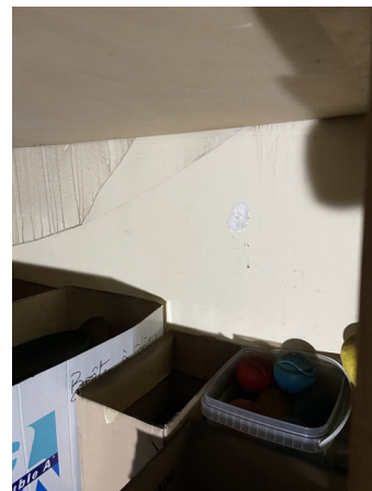
Prélèvement - P89 : RDC / Réserve 3 - Enduit- (Absence d'amiante)
