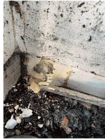
Prélèvement - P58 : RDC / Sanitaires 2 - Colle de plinthe- (Absence d'amiante)
