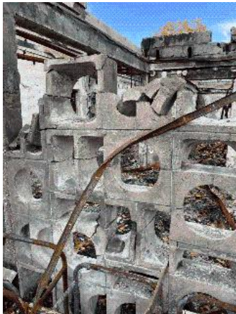
Prélèvement - P71 : RDC / Accueil - Enduit- (Absence d'amiante)
