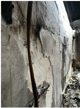
Prélèvement - P84 : RDC / Salle polyvalente - Enduit- (Absence d'amiante)
