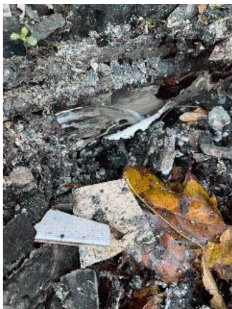
Prélèvement - P73 : RDC / Sanitaires 3 - Colle de faïence- (Absence d'amiante)
