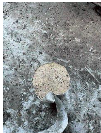
Prélèvement - P21 : RDC / Bibliothèque - Lé plastique, Colle- (Absence d'amiante)
