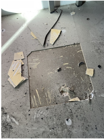
Prélèvement - P44 : RDC / Salle RPM 2 - Dalle de sol, Colle bitumineuse- (Absence d'amiante)
