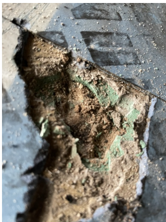
Prélèvement - P80 : RDC / Classe 6 - Dalle de sol, Colle bitumineuse- (Absence d'amiante)
