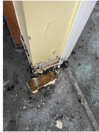
Prélèvement - P23 : RDC / Bibliothèque - Colle de plinthe- (Absence d'amiante)
