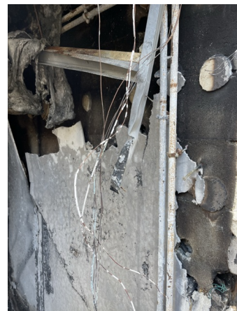
Prélèvement - P74 : RDC / Sanitaires 3 - Enduit- (Absence d'amiante)
