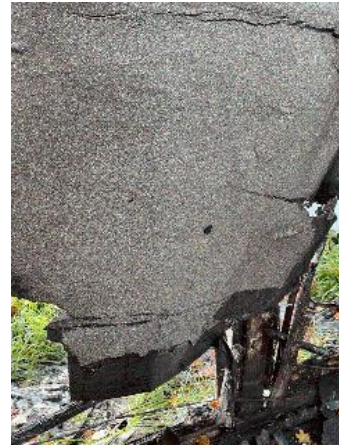
Prélèvement - P98 : RDC / Couloir 3 - Revêtement d'étanchéité - (Absence d'amiante)
