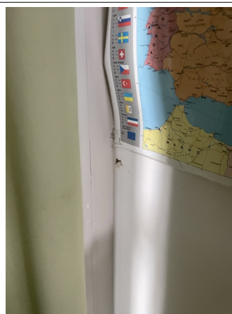
Prélèvement - P11 : RDC / Salle de réunion - Bande calicot- (Absence d'amiante)
