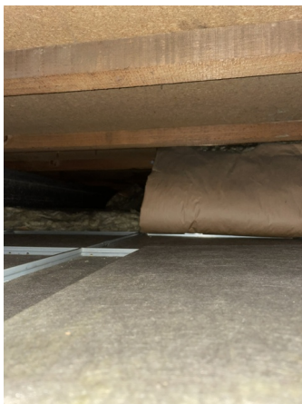
Prélèvement - P20 : RDC / Salle informatique - Isolant sur panneau de faux-plafond- (Absence d'amiante)
