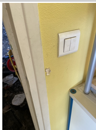
Prélèvement - P41 : RDC / Salle RPM 1 - Bande calicot- (Absence d'amiante)
