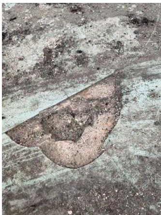
Prélèvement - P31 : RDC / Classe 5 - Ragréage- (Absence d'amiante)
