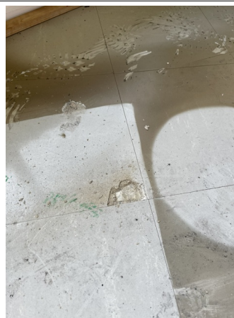
Prélèvement - P39 : RDC / Salle RPM 1 - Dalle de sol, Colle- (Absence d'amiante)
