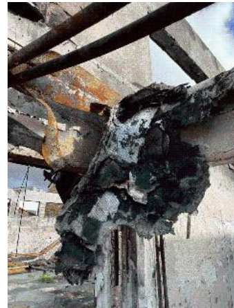
Prélèvement - P72 : RDC / Accueil - Revêtement d'étanchéité- (Absence d'amiante)
