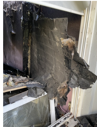
Prélèvement - P94 : RDC / Bureau 3 - Revêtement d'étanchéité - (Absence d'amiante)
