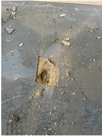
Prélèvement - P2 : RDC / Bureau 1 - Ragréage- (Absence d'amiante)
