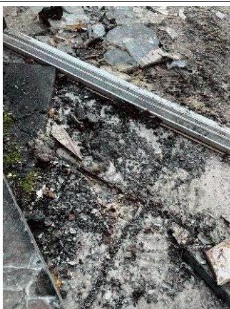
Prélèvement - P55 : RDC / Sanitaires 2 - Colle de carrelage- (Absence d'amiante)
