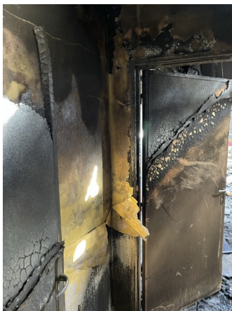
Prélèvement - P61 : RDC / Dégagement 2 - Enduit, Peinture- (Absence d'amiante)
