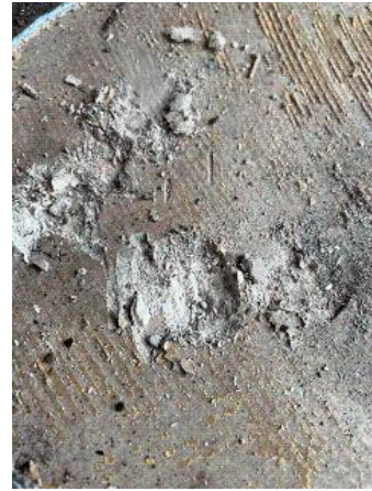
Prélèvement - P17 : RDC / Couloir 1 - Ragréage- (Absence d'amiante)
