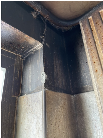
Prélèvement - P59 : RDC / Sanitaires 2 - Enduit- (Absence d'amiante)
