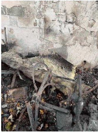
Prélèvement - P91 : RDC / Classe 8 - Isolant- (Absence d'amiante)
