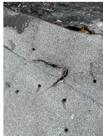
Prélèvement - P62 : RDC / Préau - Revêtement d'étanchéité- (Absence d'amiante)
