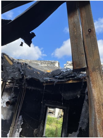
Prélèvement - P75 : RDC / Sanitaires 3 - Revêtement d'étanchéité- (Absence d'amiante)
