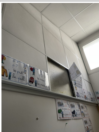
Prélèvement - P10 : RDC / Salle de réunion - Faux plafond- (Absence d'amiante)
