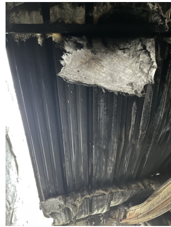
Prélèvement - P85 : RDC / Salle polyvalente - Isolant- (Absence d'amiante)
