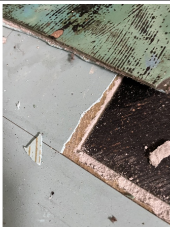
Prélèvement - P8 : RDC / Salle de réunion - Ragréage- (Absence d'amiante)
