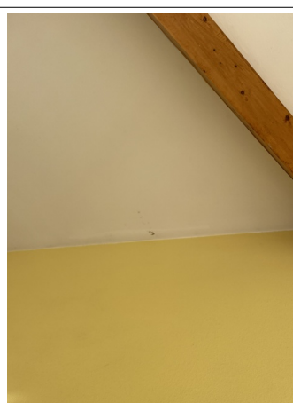
Prélèvement - P43 : RDC / Salle RPM 1 - Bande calicot- (Absence d'amiante)
