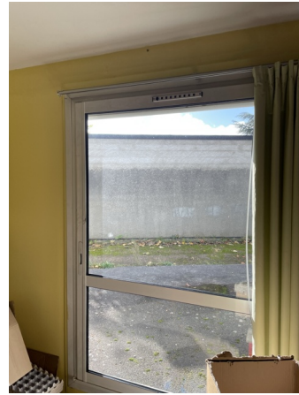
Prélèvement - P45 : RDC / Salle RPM 2 - Joint de vitrage- (Absence d'amiante)
