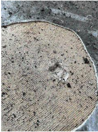
Prélèvement - P22 : RDC / Bibliothèque - Ragréage- (Présence d'amiante)
