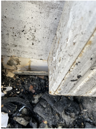
Prélèvement - P57 : RDC / Sanitaires 2 - Colle de plinthe- (Absence d'amiante)
