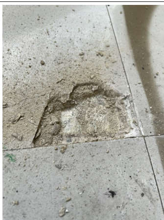
Prélèvement - P40 : RDC / Salle RPM 1 - Ragréage- (Absence d'amiante)
