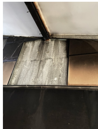
Prélèvement - P81 : RDC / Classe 6 - Enduit- (Absence d'amiante)
