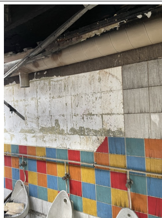
Prélèvement - P56 : RDC / Sanitaires 2 - Colle de faïence- (Absence d'amiante)
