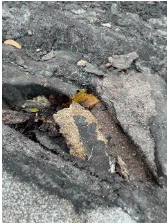
Prélèvement - P63 : RDC / Préau - Isolant- (Absence d'amiante)
