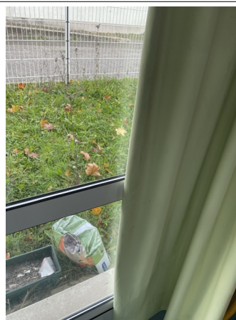
Prélèvement - P13 : RDC / Salle de réunion - Joint de vitrage- (Absence d'amiante)
