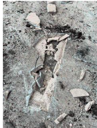
Prélèvement - P27 : RDC / Classe 3 - Colle bitumineuse, Ragréage- (Présence d'amiante)
