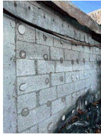
Prélèvement - P76 : RDC / Salle des maîtres - Plot de colle- (Absence d'amiante)
