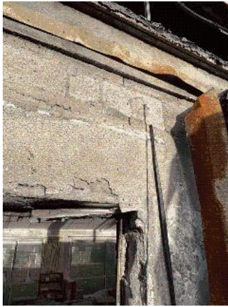
Prélèvement - P97 : RDC / Couloir 3 - Enduit- (Absence d'amiante)
