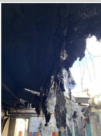
Prélèvement - P53 : RDC / Sanitaires 2 - Revêtement d'étanchéité- (Absence d'amiante)
