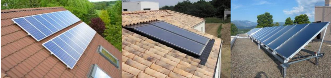
Figure 13 : Capteurs solaires thermiques sur rails (à gauche), intégrés (au milieu) et non-intégrés sur plots de fixation (à droite)
