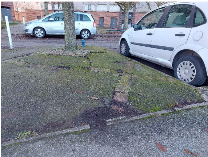
Marronnier n°12 : dégâts racinaires sur le revêtement du trottoir – on aperçoit les racines qui soulèvent le revêtement (flèche rouge)
