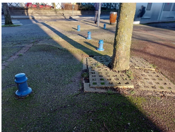
Platane n°23 et peuplier n°58 : les racines font d'importants dégâts sur le revêtement du trottoir, et soulèvent la grille en béton qui recouvre la fosse du platane
