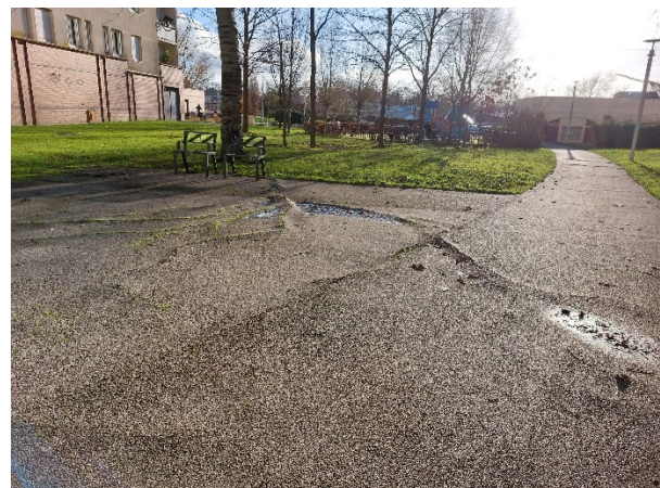
Platane n°23 et peuplier n°58 : les racines font d'importants dégâts sur le revêtement du trottoir, et soulèvent la grille en béton qui recouvre la fosse du platane
