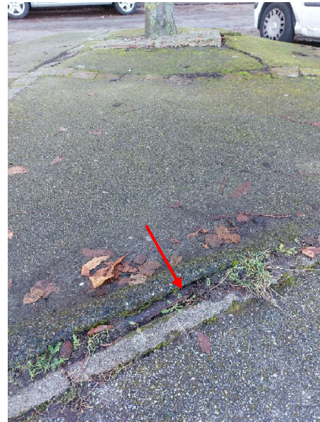
Marronnier n°12 : dégâts racinaires sur le revêtement du trottoir – on aperçoit les racines qui soulèvent le revêtement (flèche rouge)
