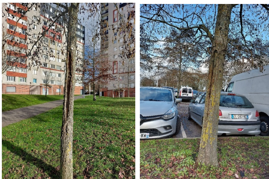
Aulnes n°166 et 204 : plaie de brûlure solaire sur le tronc
