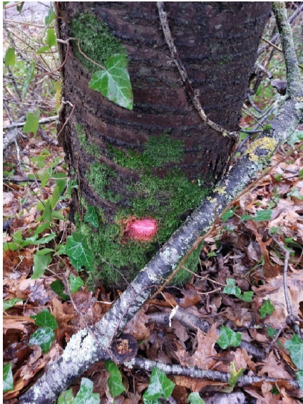
Marquage indiquant la nécessité de supprimer une branche morte
