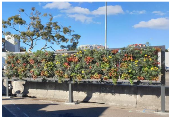
Figure 10 : Exemple de système de biofiltration d'air : Panneaux végétalisés biofiltrants installés le long d'une autoroute (University of Technology Sydney, 2019)
