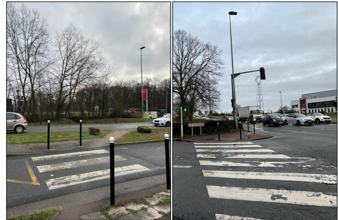
Photographie 2 : Traversées piétonnes au carrefour des Libertés
