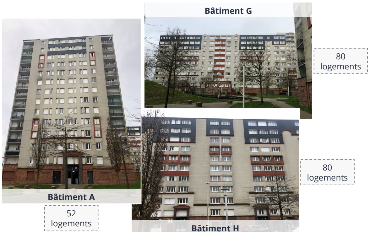
Façades des bâtiments A, G et H destinés à être démolis dans le cadre du projet NPNRU
