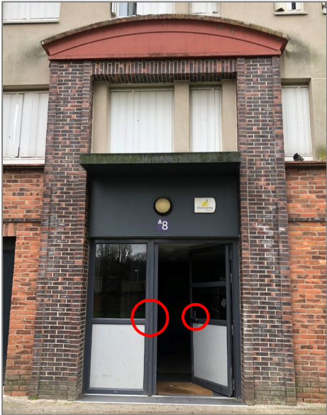
Entrée du bâtiment A
