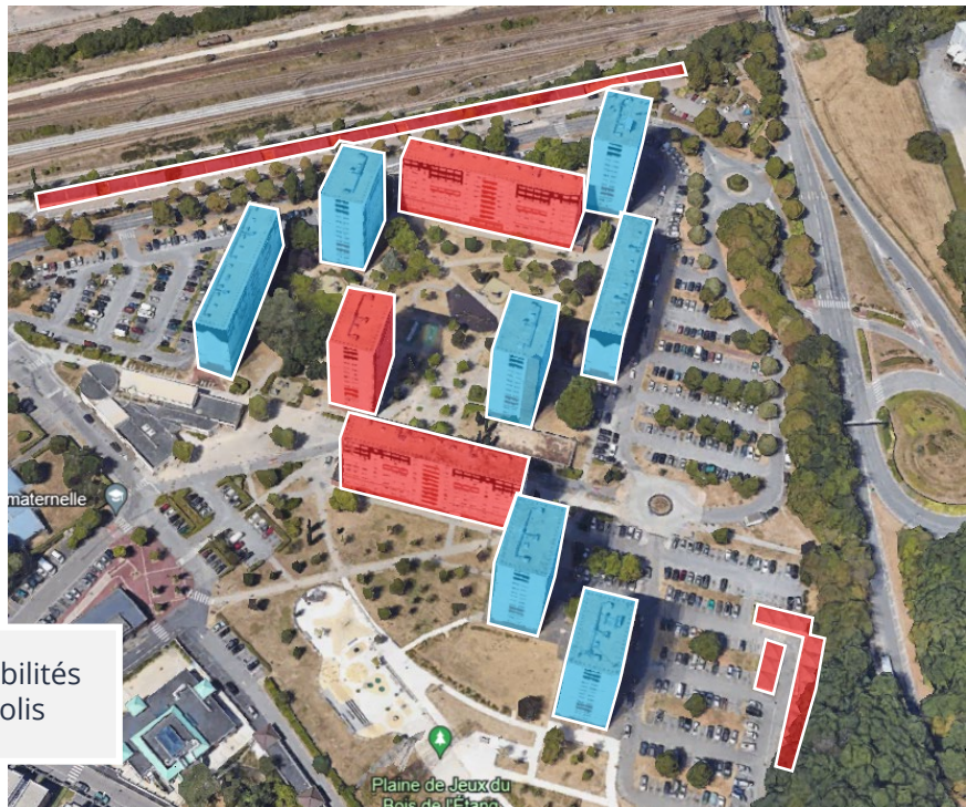
Etat actuel du quartier du Bois de l'Étang – La Verrière
