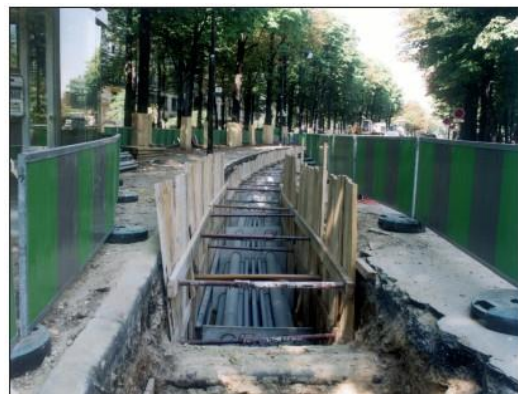
Tranchée lors de la pose d'une liaison double en PVC
