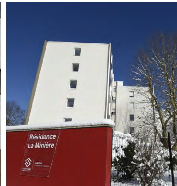
Résidence La Minière Guyancourt
