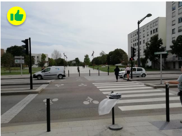
Montigny : traversée vélo parallèle au passage piéton, avec pictogrammes, pas de panneau, feu piéton uniquement
