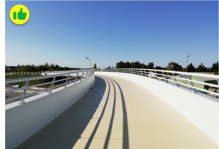
Elancourt / Plaisir : pont sur la N12
