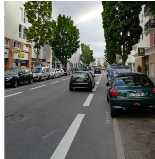
Montigny : stationnement rétrécissant la CVCB ; le cycliste aura tendance à rouler au milieu pour éviter l'emporiage
