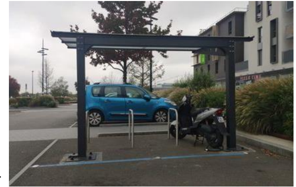
Intégré dans un parking VL
