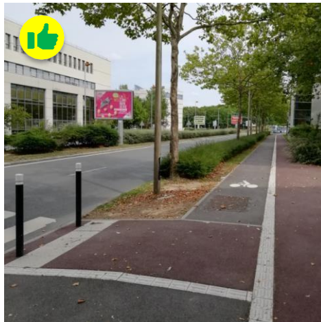
Guyancourt : Aux débouchés des passages piétons, le revêtement et une bande rugueuse avertissent le cycliste
