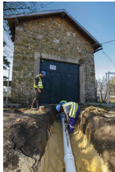
Pose d'un collecteur
