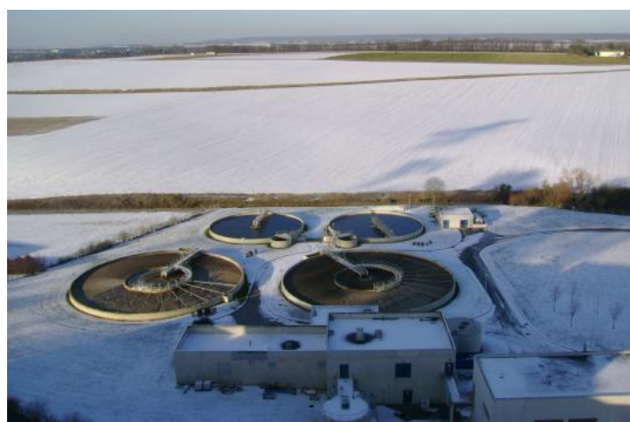
Figure 70 – STEP du val des Eglantiers en hiver (Rapport STEP CASQY, 2016)
