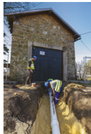
Pose d'un collecteur
