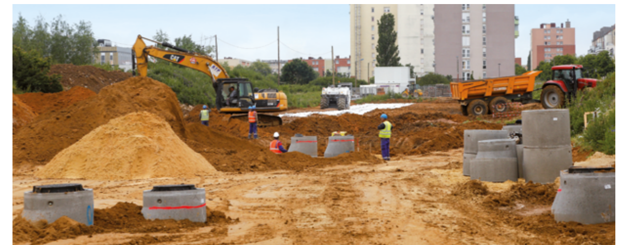
Pose de regards de visite.
