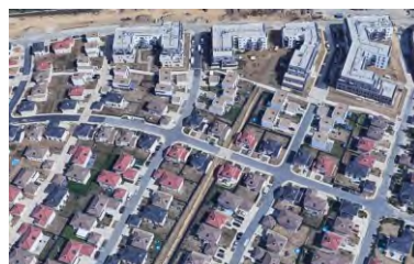
Seconde tranche de l'opération des Hauts du Moulin à partir de 2017
