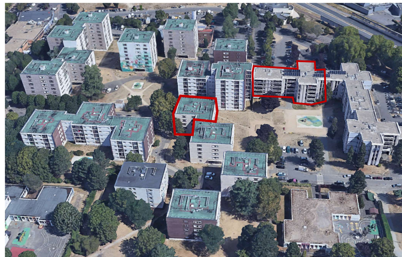
Vue des logements à démolir dans le cadre du projet (Google Earth)
