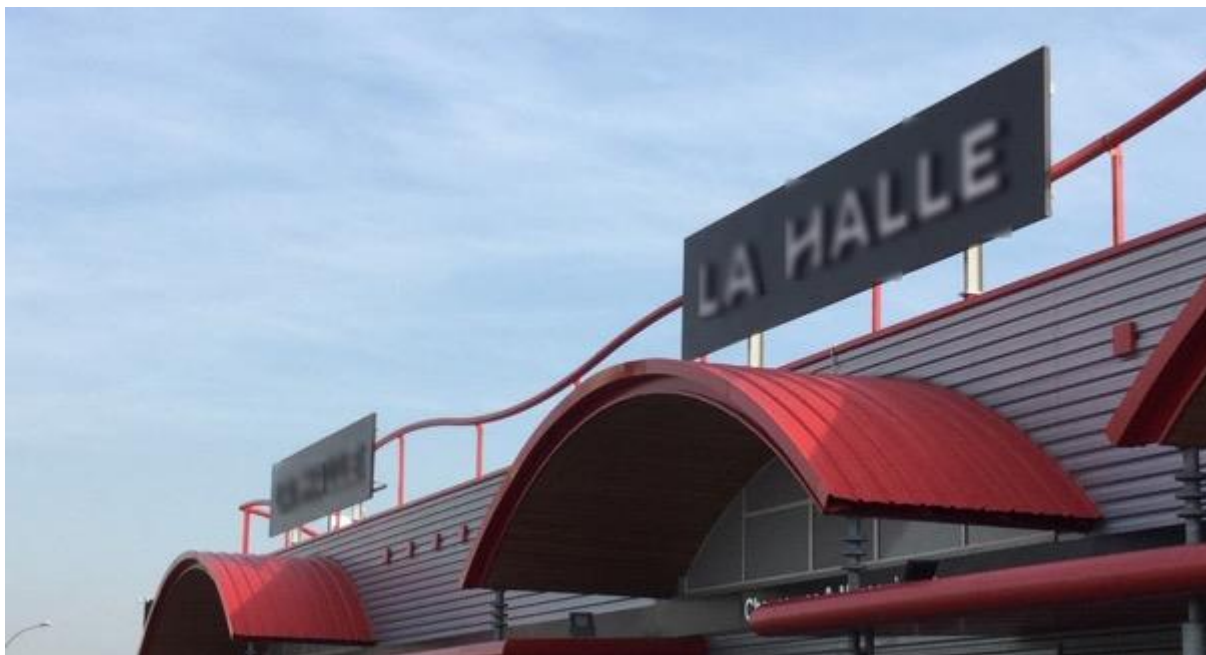
Enseigne sur toiture avec un panneau de fond (non conforme), Maurepas, 2017
