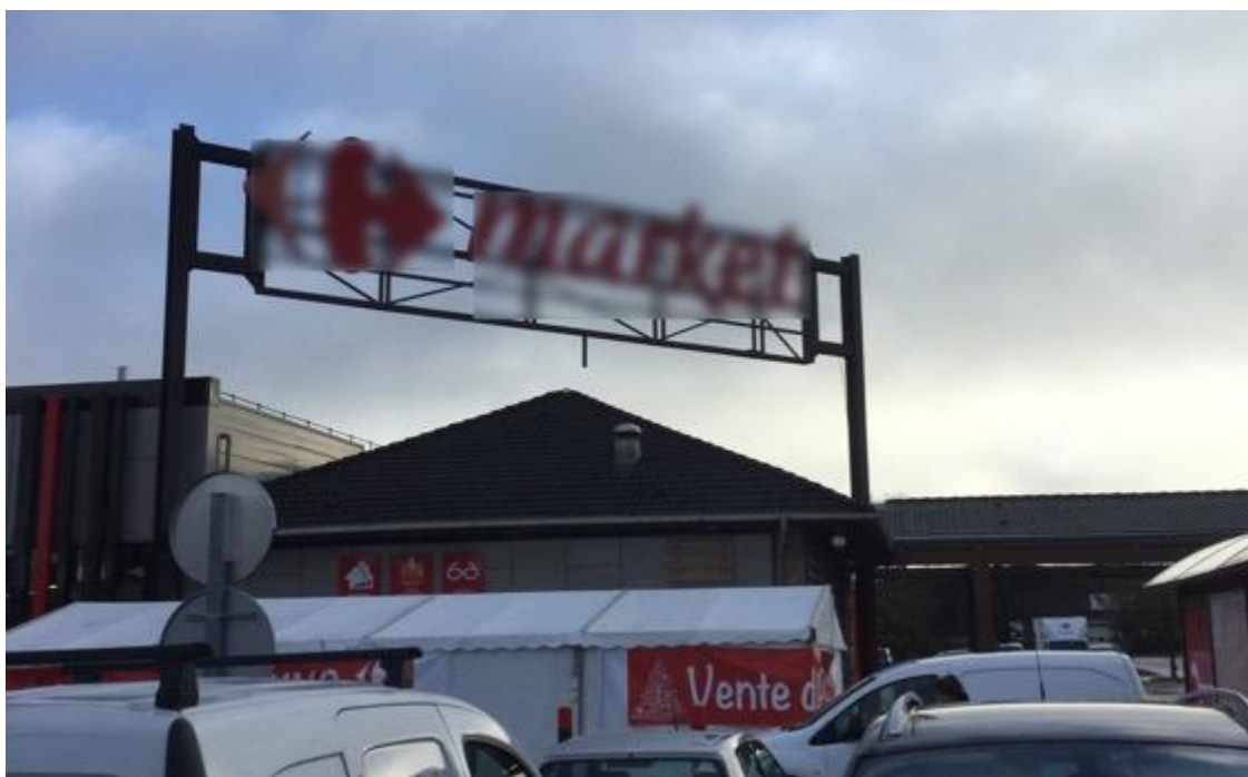
Enseigne scellée au sol de grand format dépassant 12 m 2 (non conforme), Voisins-le-Bretonneux, 2017
