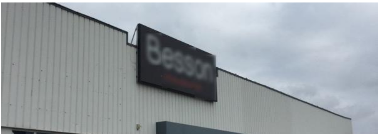
Enseigne parallèle dépassant les limites du mur (non conforme), Coignières, 2017
