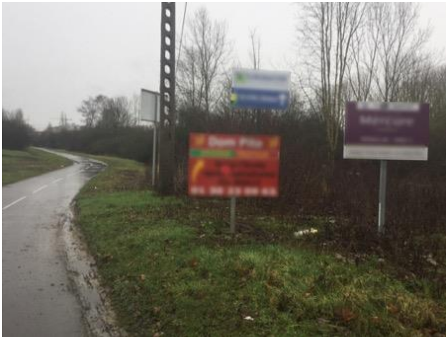
Forte densité de dispositifs scellés au sol (non conforme), Montigny-le-Bretonneux, 2017
