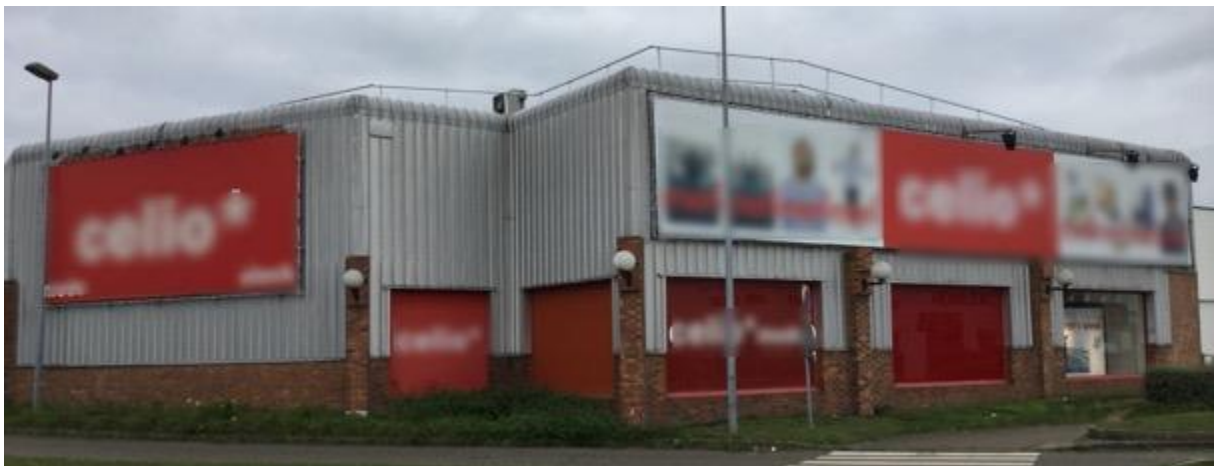
Enseigne parallèle dont la surface dépasse la proportion par rapport à la façade (15%) (non conforme), Coignières, 2017
