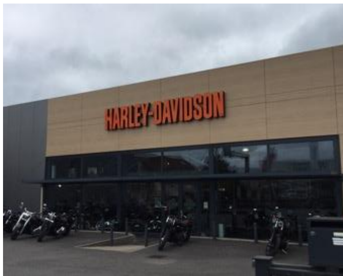
Enseigne parallèle bien intégrée à l'architecture de la façade, Coignières, 2017
