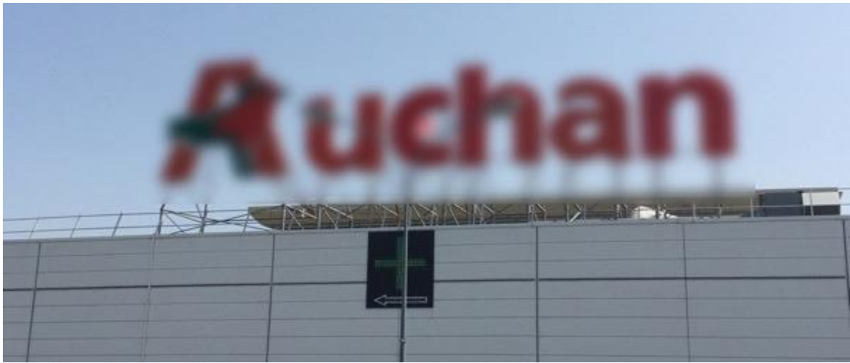
Enseigne sur toiture dépassant les 60 m 2 (non conforme), Plaisir, 2017
