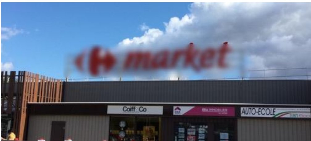
Enseigne sur toiture de 24 m 2 , Villepreux, 2017
