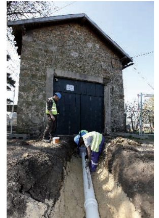
Pose d'un collecteur
