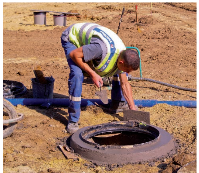
Travaux de maçonnerie sur regard
