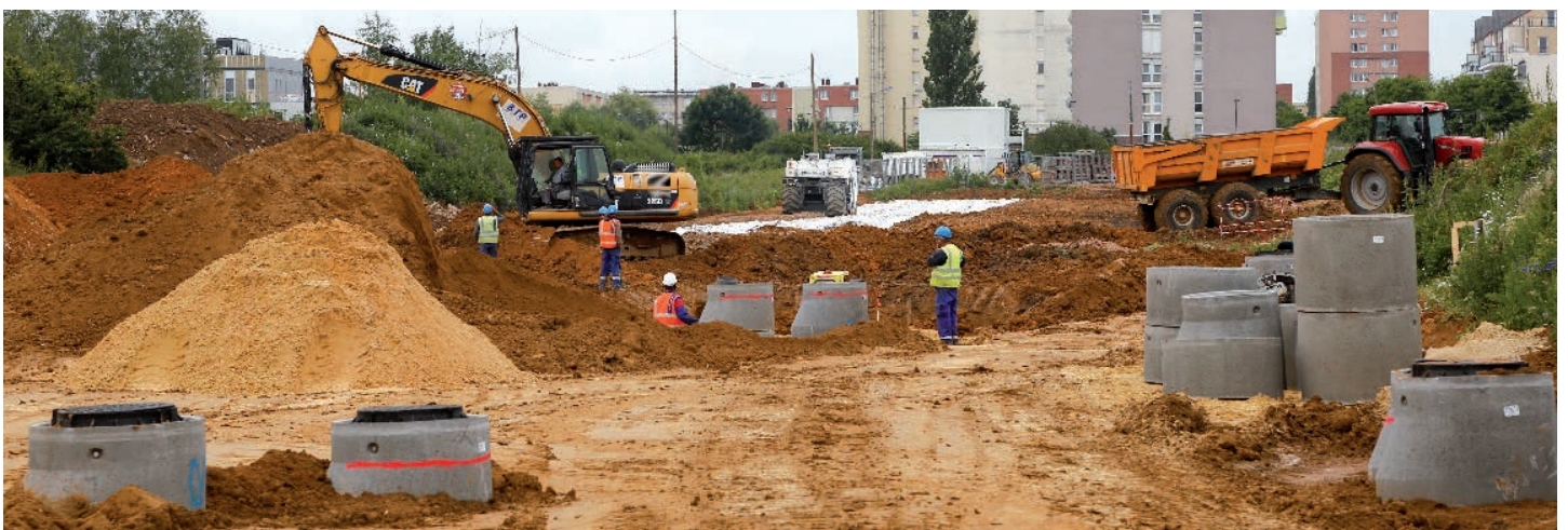
Pose de regards de visite
