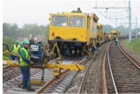
Rails courts sur traverses bois & Longs Rails soudés sur traverses béton
