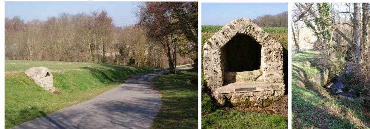
L'exutoire de la fontaine est également colmaté. Les eaux quittent l'ouvrage en recherchant dans l'accotement en herbe de la route, l'ancien axe d'une rigole, puis débordent sur la chaussée.
