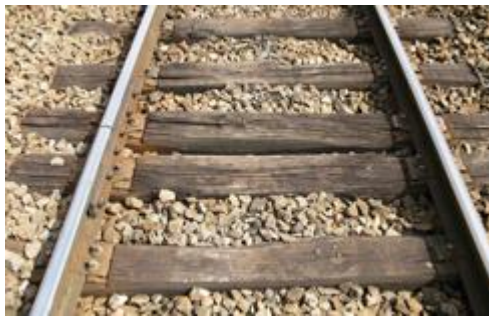
Rails courts sur traverses bois & Longs Rails soudés sur traverses béton
