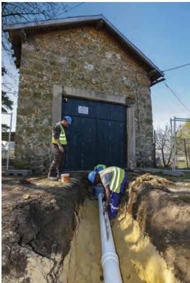
Pose d'un collecteur
