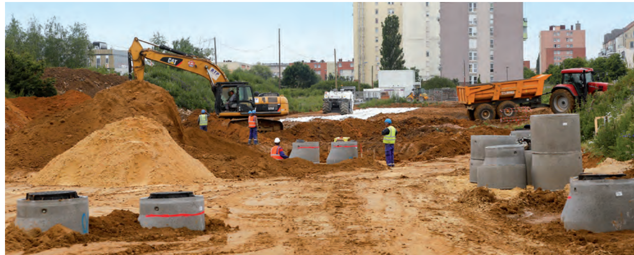
Pose de regards de visite.
